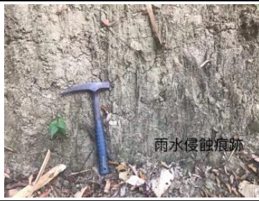
圖 1-39 岩壁上可看出雨水侵蝕痕跡。
