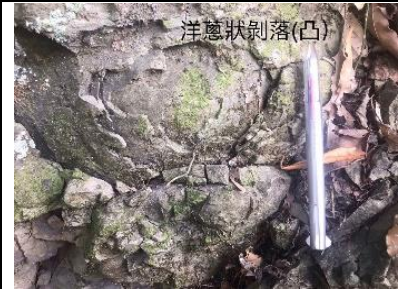
圖 1-34 頁岩層理不明，容易崩塌，剝落後呈現球狀，且破面凌亂。
