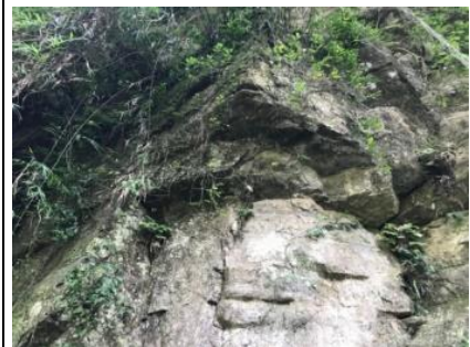
圖 1-7 露頭下方逐漸被侵蝕，因此上方的岩壁未來可能會崩落。
