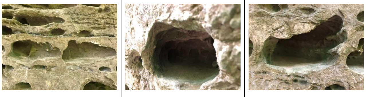
圖 2-1、圖 2-2、圖 2-3 觀察到地層中的洞，大部分都是面對洞的左側深度都比較深
