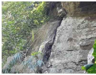
圖 1-6 圖中的裂縫為「節理」，節理是岩石受力後，所產生的破裂面。
