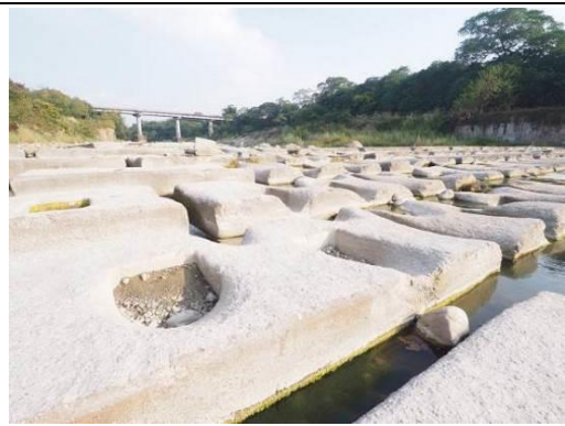
圖 1-55 這裡許多水泥做的固床工，它主要的功能是避免河水再向下切，侵蝕河床
