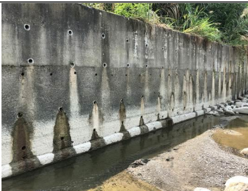
圖 1-11 這裡有一大排的堤岸，他是用鋼筋水泥和混凝土做的。護岸的垂直面有一些排水孔。
