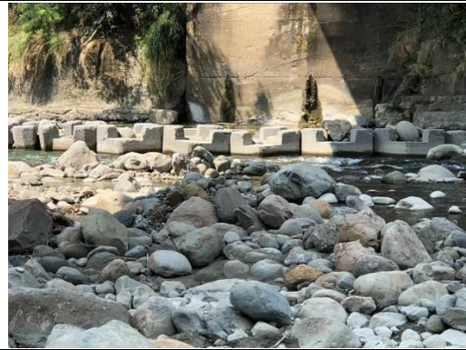
圖 1-10 在河流旁可以看到不少的消波塊，這些消波塊的作用是為了不讓河流繼續侵蝕河岸。
