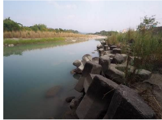
圖 1-50 河流的旁邊有很多消波塊，保護河岸避免被侵蝕，這裡的水很平靜，可見坡度是平緩的。
