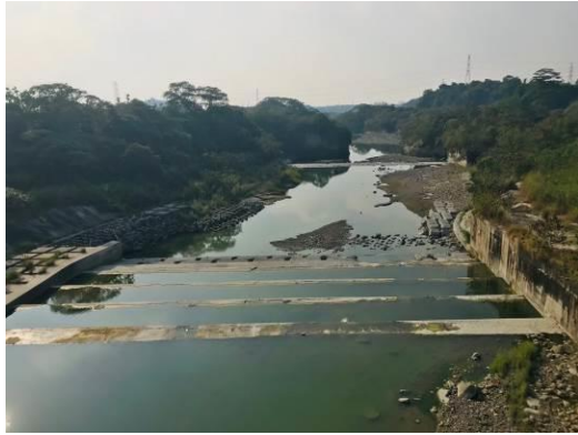
圖 1-43 新五虎寮橋的下方，向西是防砂壩，為了避免河岸被侵蝕。
