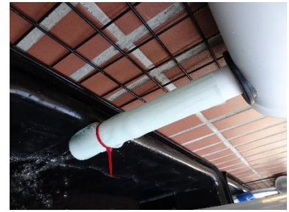
(3)開啟馬達測試水的循環
