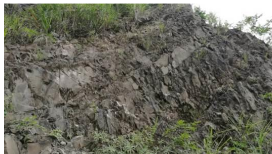
圖 5-2 露頭五層面為褐灰色砂岩夾雜黑色頁岩，表面破碎嚴重節理明顯，下方的岩層是塊狀的砂岩；傾斜方向是北偏西 10 度，傾斜 52 度。
