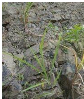
圖 1-17 南庄層由砂岩、頁岩、砂質頁岩所組成，厚度約 1,000m，在調查區域內的岩層解理發達，破碎情形很嚴重。
